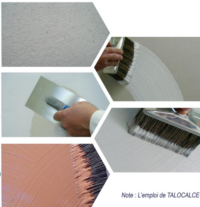
2 Si nécessaire, application à la brosse à chauler d'une couche d'IMPRIM CHAUX (dilution 0 à 10% d'eau).
